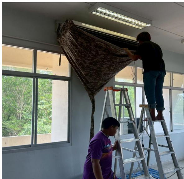
ภาพ การล้างทำความสะอาดเครื่องปรับอากาศ
