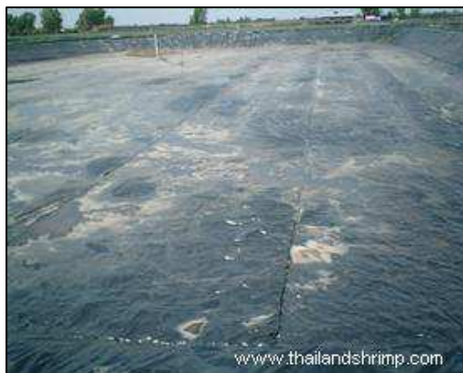
ภาพที่ 2 ภาพบ่อที่ปูด้วยโพลีเอททิลีน PE
